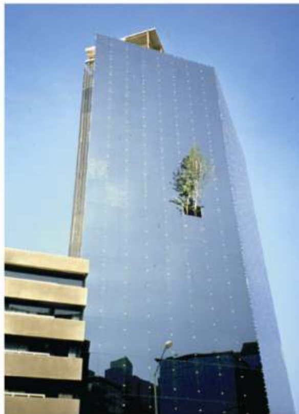
Figura 2. Edificio típico con características de arquitectura de estilo internacional
