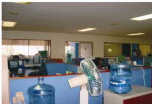
Figura 6. Equipos electromecánicos para movimiento del aire durante periodo de sobrecalentamiento en el espacio analizado.
