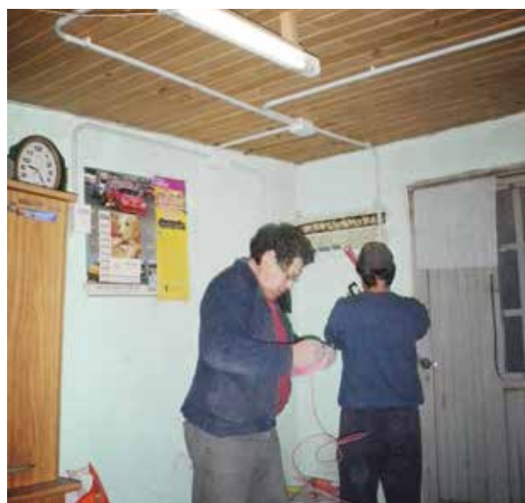
Arriba. Instaladores en acción.
