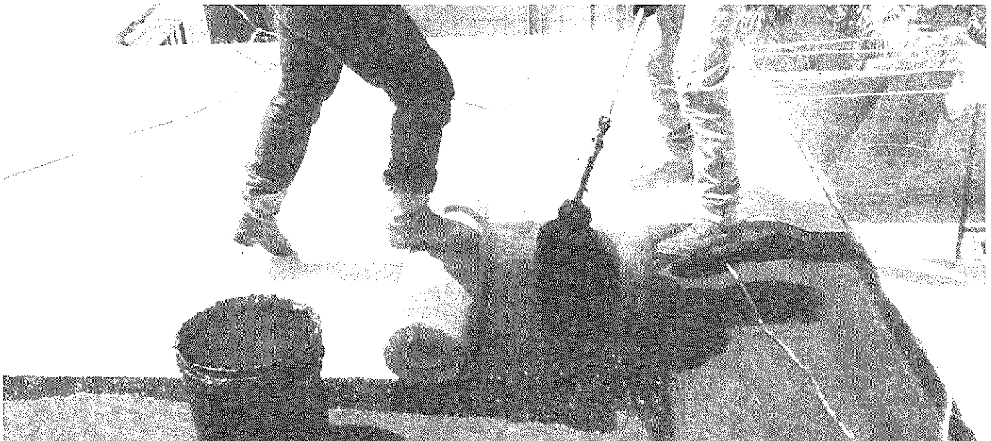
Aislamiento térmico de techos.
