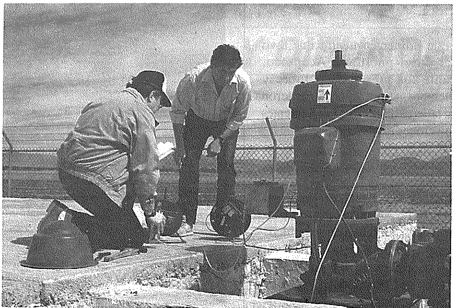
El mantenimiento de motores es ahorro de energía
