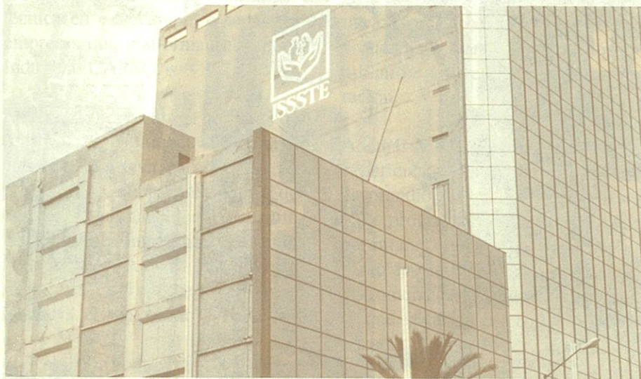
Instalaciones del ISSSTE en Av. de la República
